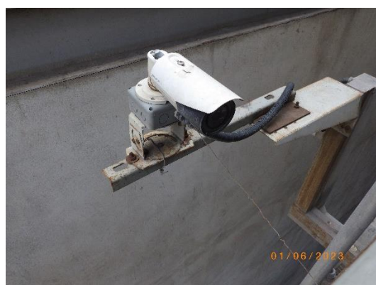
รูปที่ 2-59 การติดตั้งกล้องวงจรปิดสำหรับตรวจสอบ ระดับน้ำใน steam drum จากระบบเครื่องวัดระดับน้ำ แบบ bi-color
