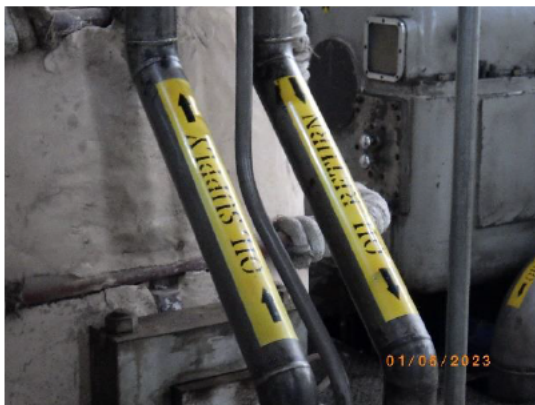
รูปที่ 2-65 ระบบท่อน้ำมันเลี้ยงแบร์ริงของ Turbine & Generator
