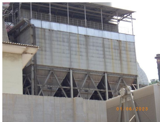
รูปที่ 2-9 ระบบ Bag Filter
