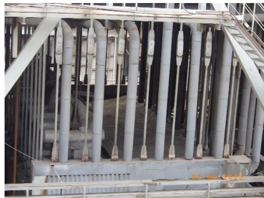
รูปที่ 2-58 Rapid Drain Piping System ของหม้อไอน้ำ
