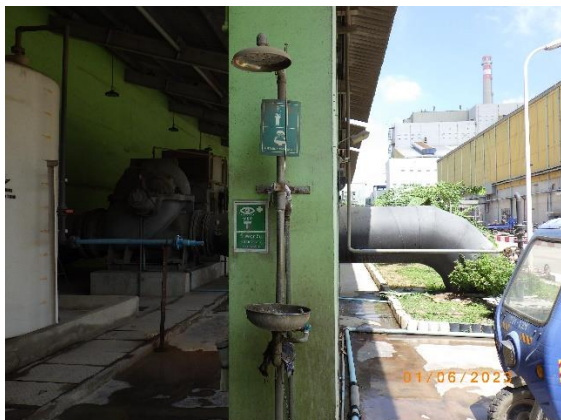
รูปที่ 2-45 ที่ล้างตาฉุกเฉิน
