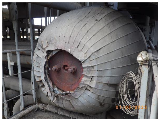
รูปที่ 2-54 Steam Drum ของหม้อไอน้ำ
