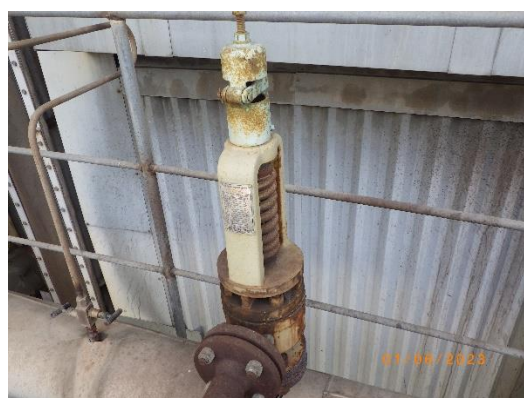
รูปที่ 2-56 Safety Valve ของหม้อไอน้ำ
