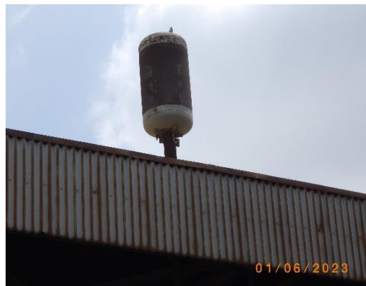
รูปที่ 2-13 อุปกรณ์ลดเสียง (Silencer)
