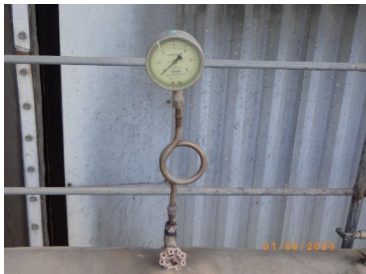
รูปที่ 2-57 Pressure gauge ของหม้อไอน้ำ
