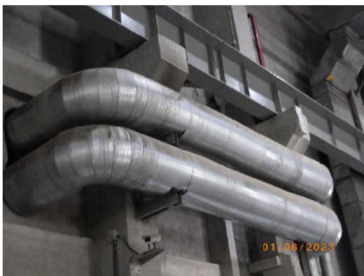
รูปที่ 2-40 ฉนวนกันความร้อน บริเวณระบบท่อไอน้ำ
