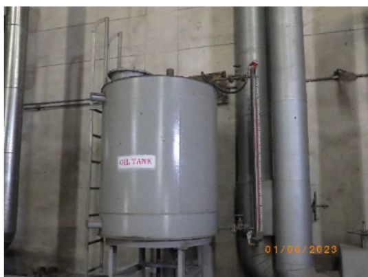
รูปที่ 2-67 การติดตั้ง Emergency Gravity Oil Tank ภายในโรงไฟฟ้า
