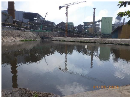
รูปที่ 2-18 บ่อพักน้ำทิ้งขนาด 20,000 ลบ.ม.
