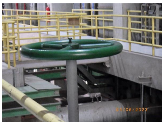
รูปที่ 2-55 อุปกรณ์ควบคุมการไหลด้วยมือ
