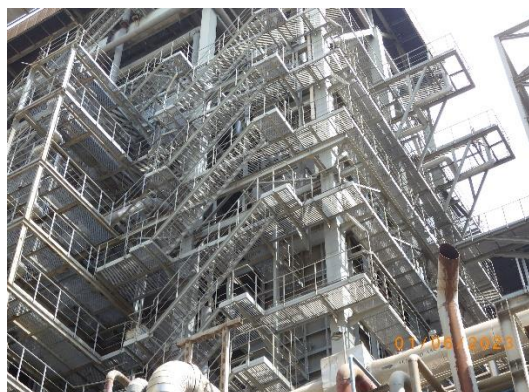
รูปที่ 2-53 ตัวอย่างอาคาร Boiler ที่มีทางเดินและบันได พร้อมราวกันตก
